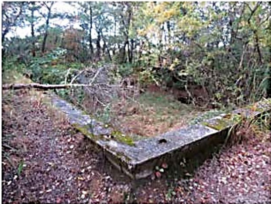
図6 第二区貯水槽
