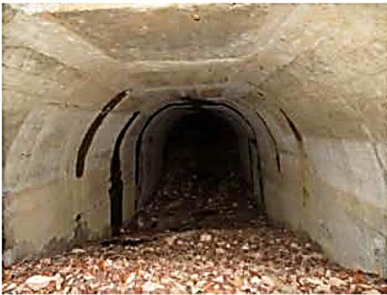
図4 第一区第7坑口
