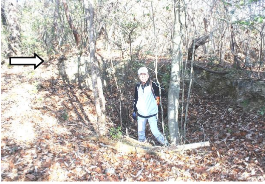
南側 ①第2区尾根沿いの陥没穴
