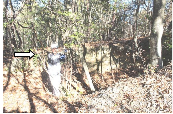
北側 ②第2区尾根沿いの陥没穴
