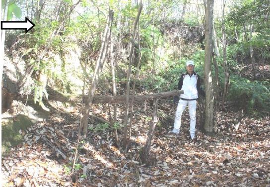
③第2区第11坑の陥没溝
