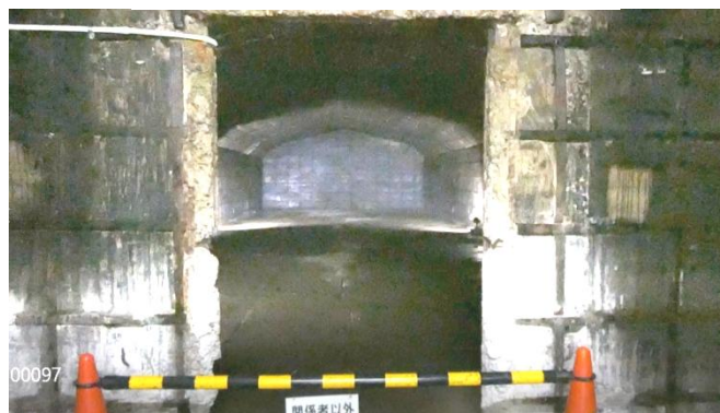
火薬庫内部のようす（左図の奥）
