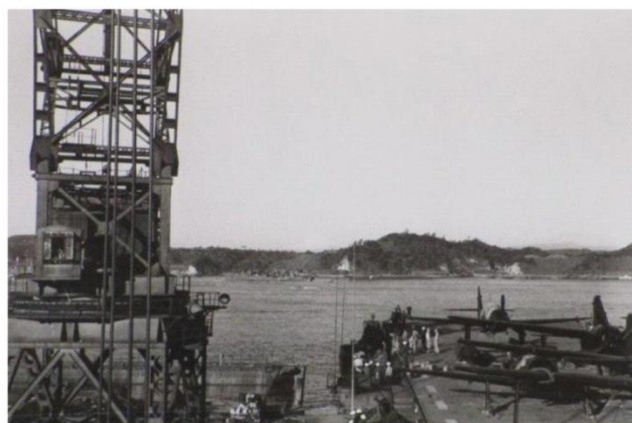
⑩横須賀第 6 ドライドックに横づけされた空母コアにガントリークレーンを使って搭載された強風、晴嵐、他
