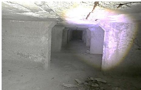
洞窟・半洞窟とも、魔法瓶のように火薬庫の周りを人が一人通れるぐらいの通路が設置され床下はコンクリートの柱で支えられていました。
