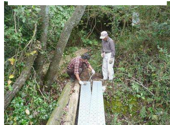
10月22日(土) 地下工場跡地北の用水路を 渡る橋の一部が破損していたため、新しく工事 用の足場を使って整備を行いました。
